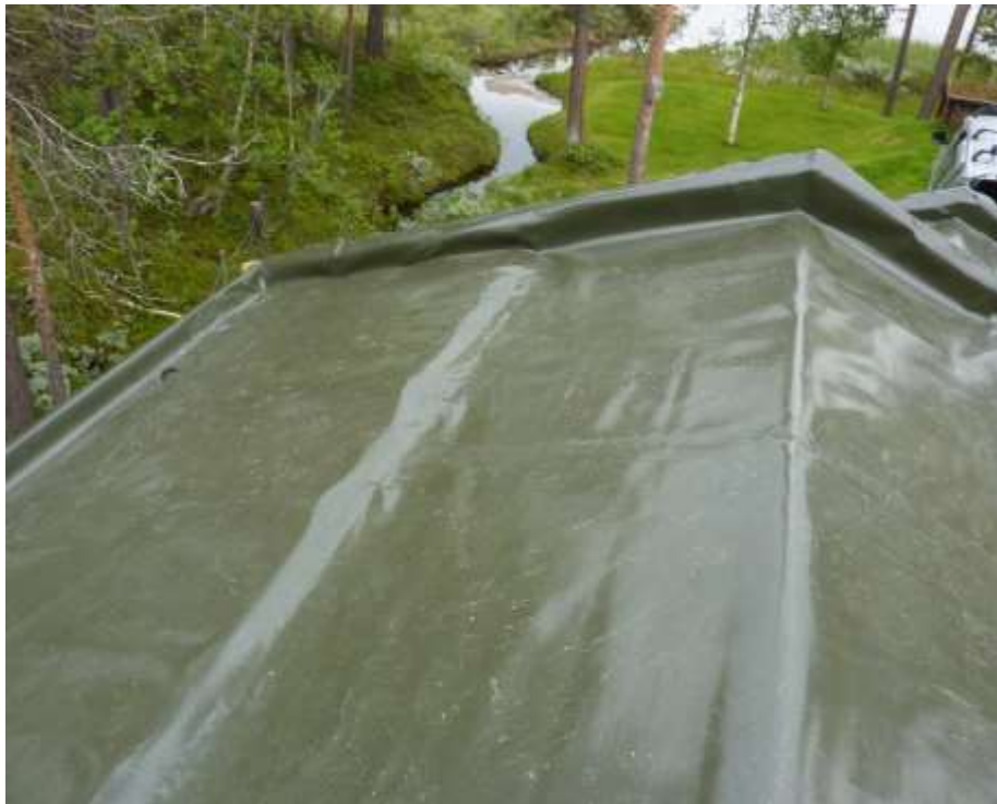
TM Vanntett ferdig montert og klar for torvtak.
